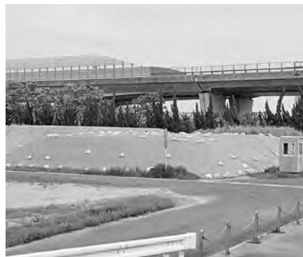
ストックヤードでブルーシートに覆われた残土
