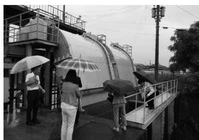
▲大内川サイホン施設修繕工事
