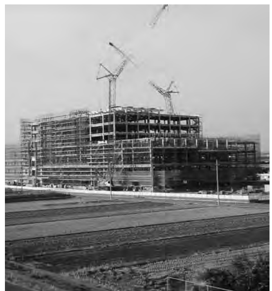
公園予定地と建設中の第二岡本病院
