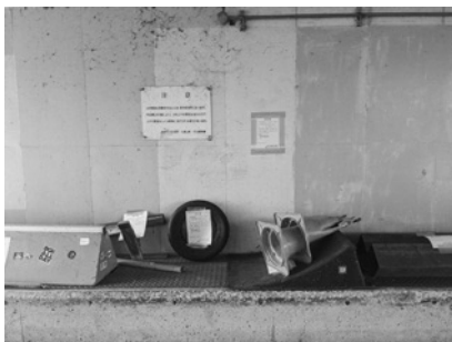
大内川地下道の放置物（9月8日撤去）
