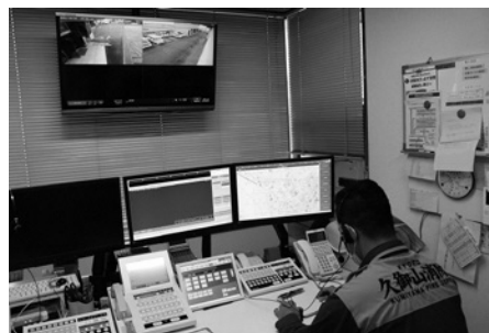
本町消防署指令センター
