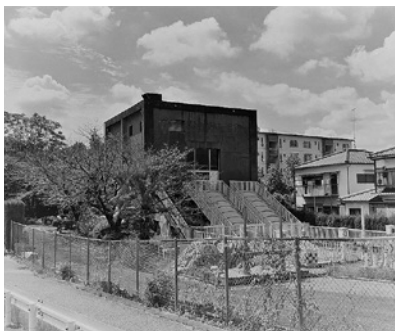
佐山排水機場
