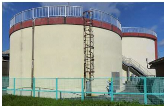
写真 2.8 場外施設配水池
