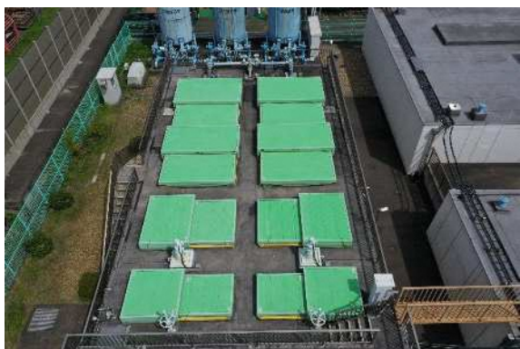
写真 2.5 浄水処理施設全景
