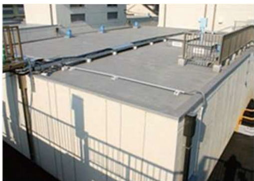
写真 2.7 佐古浄水場配水池
